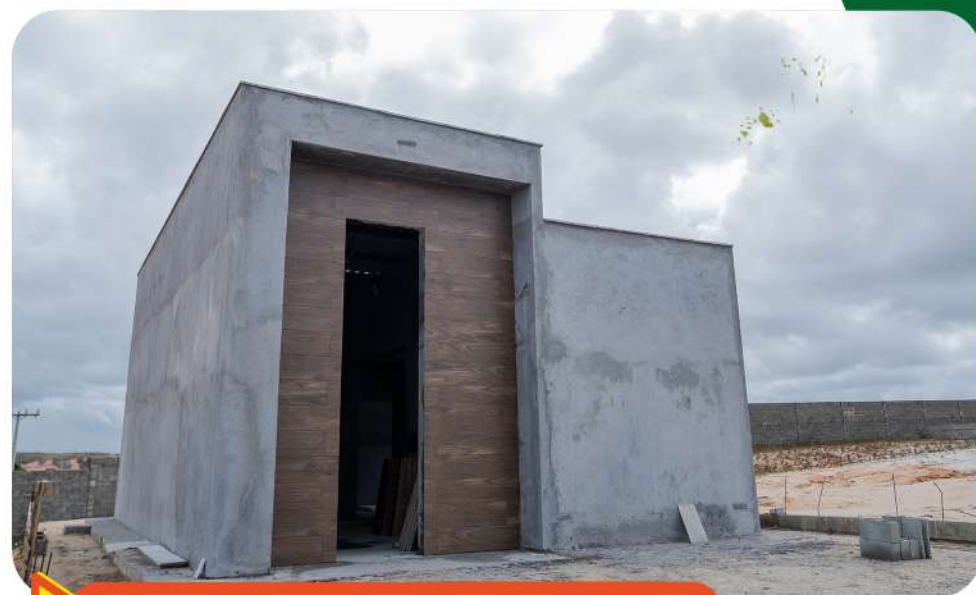
Foto real da casa em construção
